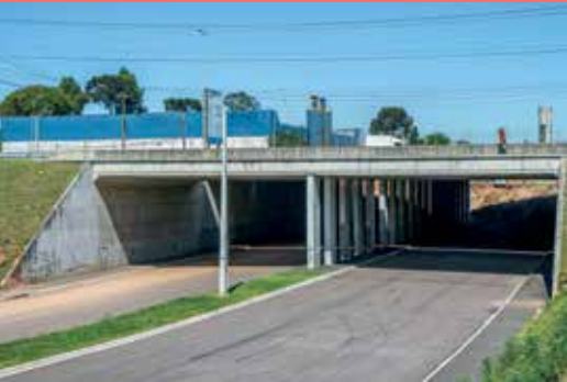
Prefeitura constrói o acesso à trincheira da Ceasa, na BR-116
