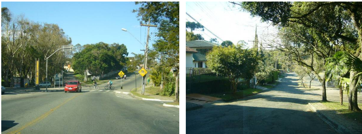
FIGURA 27: VISTAS DA ZONA DE ENTORNO DO PARQUE NATURAL MUNICIPAL SÃO LOURENÇO Fonte: ECOTÉCNICA (2009)
